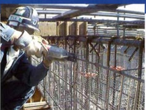
専用工具(エアーニッパー)でセバの締付を行います。
