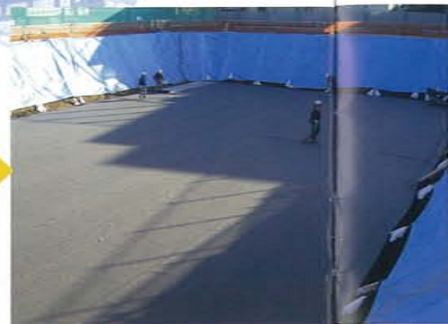
3 保護シート(1重目)施工 *透水タイプは、1重のみとなります。
