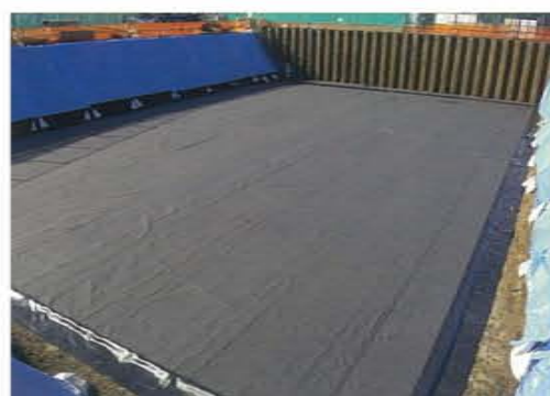
5 保護シート(2重目)施工 *透水タイプは、1重のみとなります。
