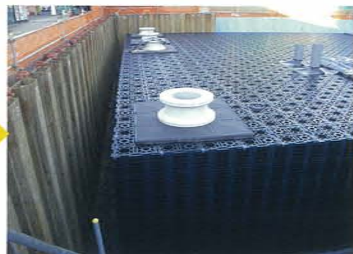
8 ユニット組立完成
