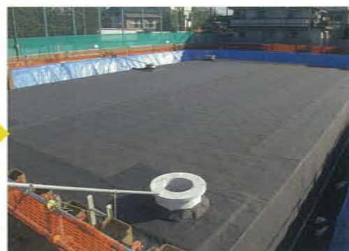
10 シート収め/組立完了
