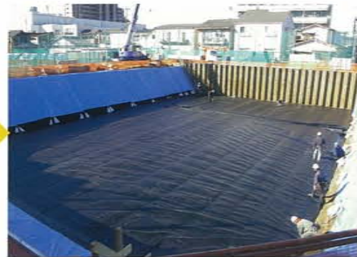
4 遮水シート施工 *透水タイプは不要です。
