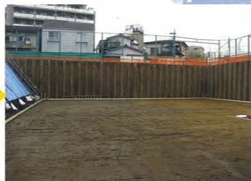
2 掘削/基礎工事
