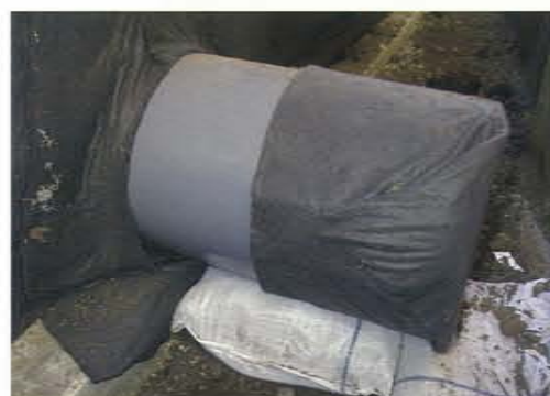
9 流出接続管/管周工
