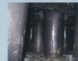
流出接続管付近 点検孔部 ほぼ土砂堆積なし
