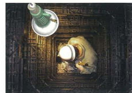
作業員が貯留槽内に入って清掃が可能です。 *必ず作業要領書に従い、換気などを行ってください。
