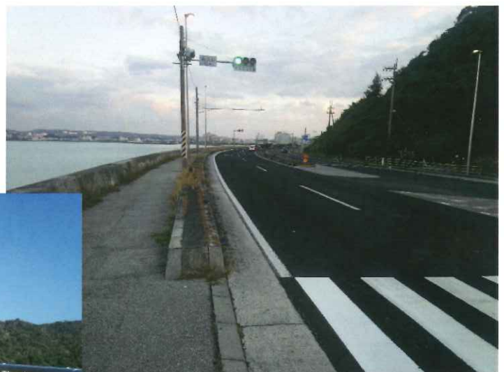
◆ニート工法 施工例
