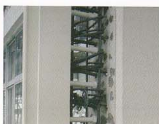
スパイラル筋+アルミ枠
