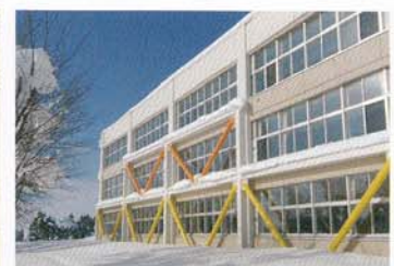
深川市立深川中学校／北海道
