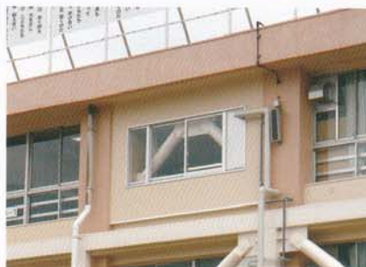
練馬区立南ヶ丘小学校／東京都 平成 22 年 9 月竣工 13 構面
