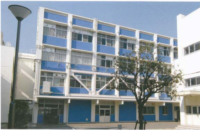
大阪府立布施工科高等学校／大阪府
